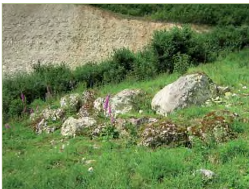
Figure 54 Exemple d'enrochement artificiel sur un talus de remblai
