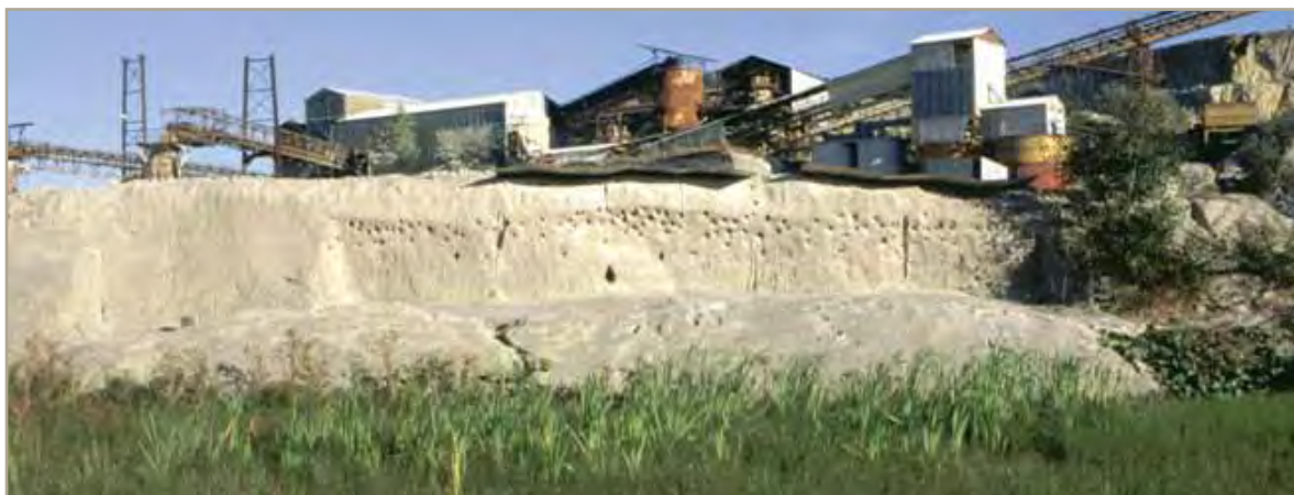
Vue sur la paroi formée par compactage du calcaire broyé, installée au contact d'une zone humide.
