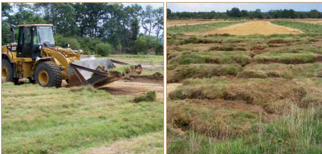
Travaux de déplaquage
