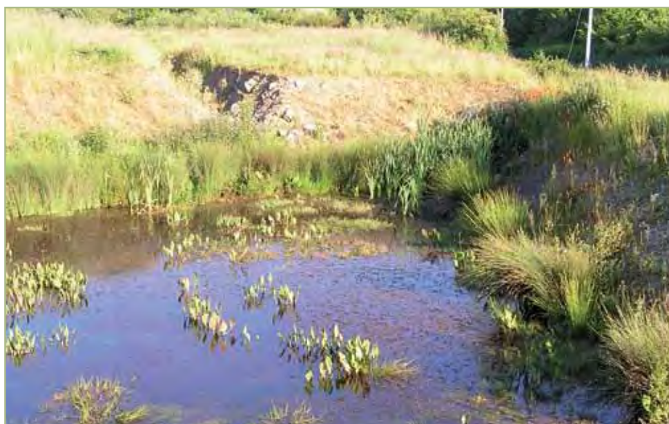
Figure 60 Bassin de décantation des eaux de ruissellement d'un remblai
