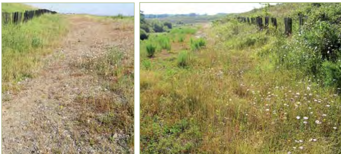
Figure 57 Pelouses sur les banquettes empierrées d'un remblai
