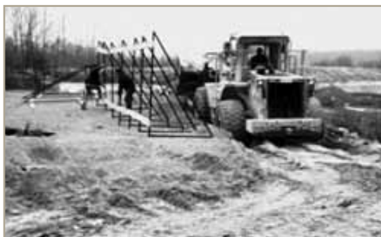
Mise en place du coffrage (éléments 3 et 4 sur le schéma ci-contre).
