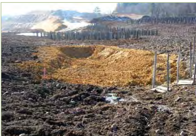
Figure 59 Aménagement de mares sur substrat drainant
